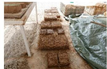
Réaliser des torchis afin de remplir une ossature par tressage de torches ou quenouilles sur une structure verticale et horizontale, en sélectionnant les fibres adaptées à la technique de l'ouvrage à réaliser, en anticipant les conditions de séchage et le retrait éventuel, en tenant compte de l'application d'une finition et en tenant compte du cahier des charges et de la commande client.
