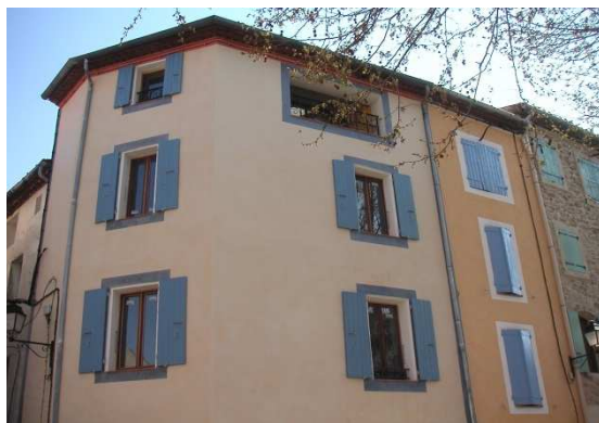
Ensemble de façades traitées en stucs adjuvés
