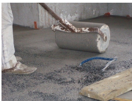
Sélection des granulats et damage dans la chape fraîche.
